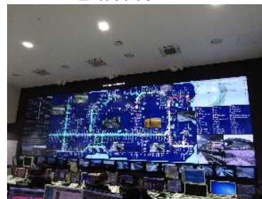
道路管制センター
