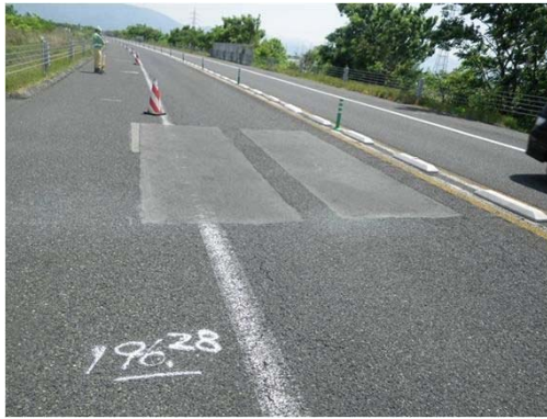
舗装路面の状況(安田IC～三川IC間)
