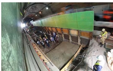
② 掘削～型枠～コンクリート打設
