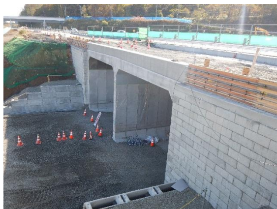
【函渠設置完了】
