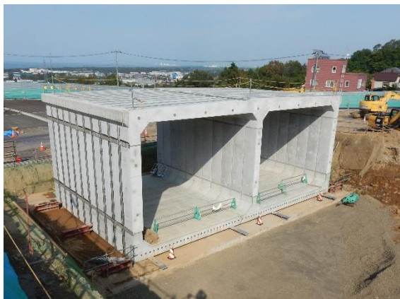
【函渠組立完了】
