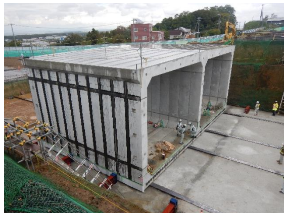
【函渠施工状況】(押し出し移動)
