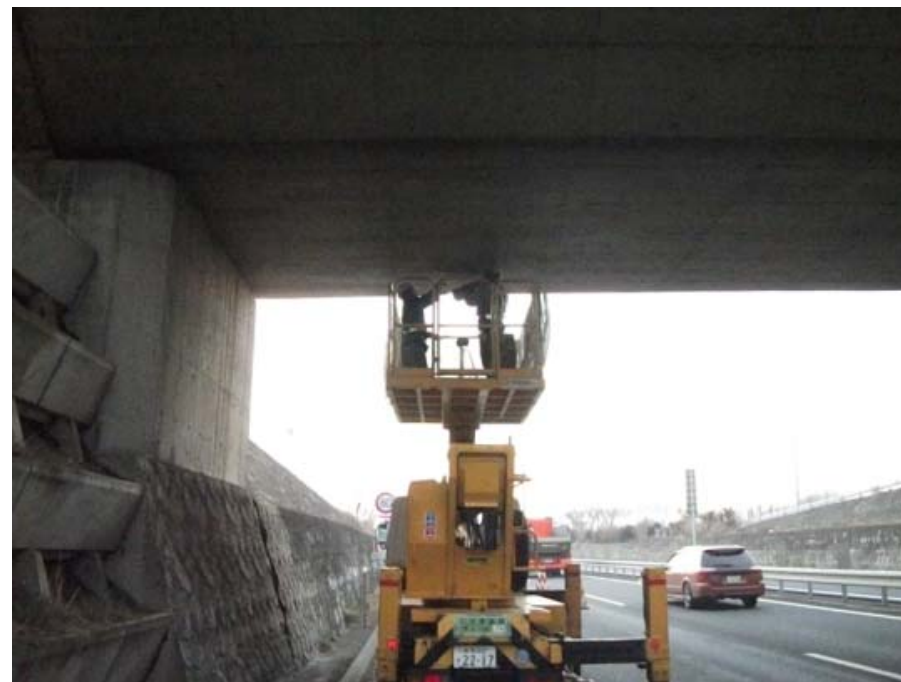
跨高速道路橋の点検
