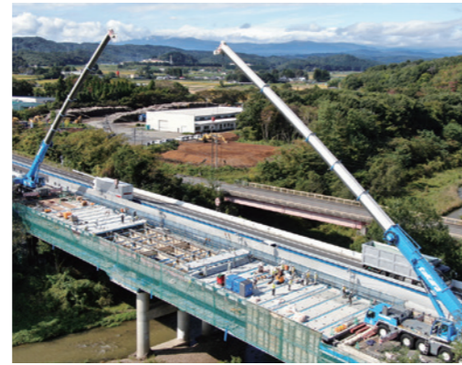
工事実施状況
