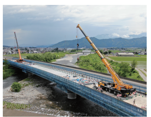
工事実施状況(イメージ)
