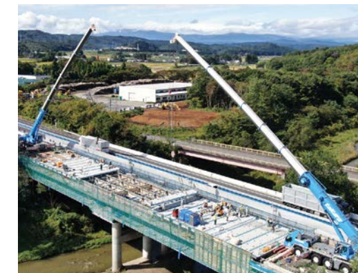
工事実施状況
