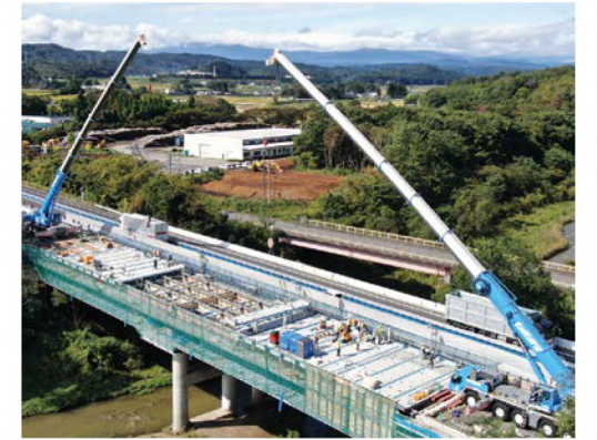
工事実施状況
