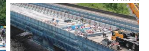
工事実施状況
