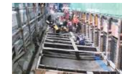
トンネルインバート打設工事(例)
