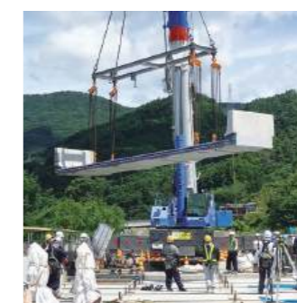
床版取替工事(例)
