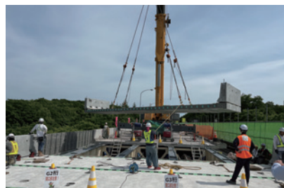
新しい床版設置状況
