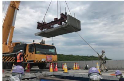
古い床版撤去状況
