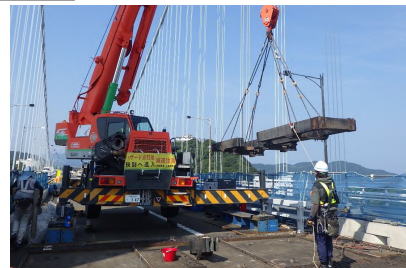
(新)大型伸縮装置の設置作業状況
