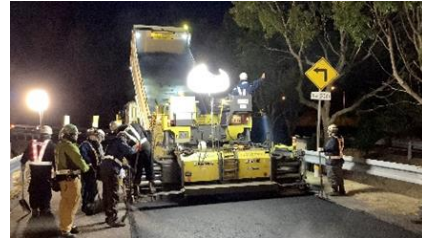
舗装補修工事 作業状況
