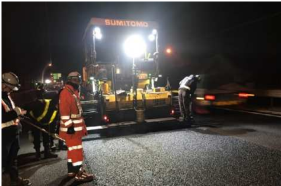
舗装補修工事 作業状況
