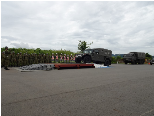
道路段差補修訓練後の走行確認
