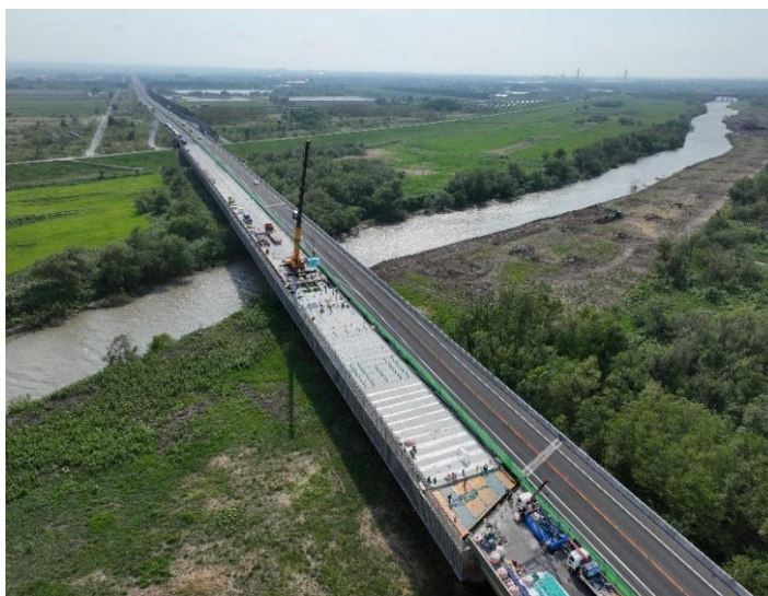
【対面通行規制状況】
