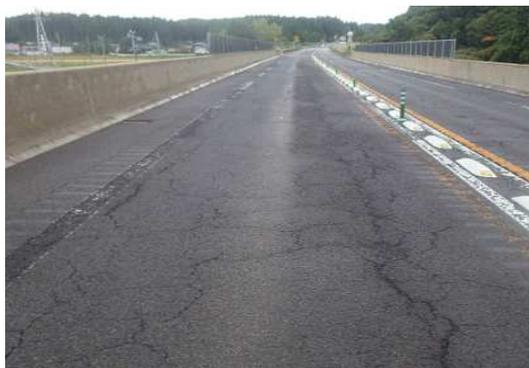
舗装損傷写真 ※応急補修済み
