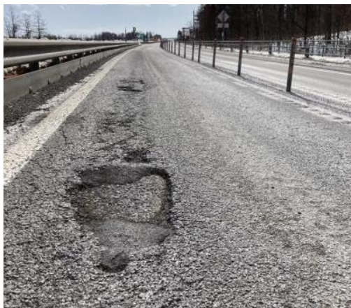
路面損傷状況
