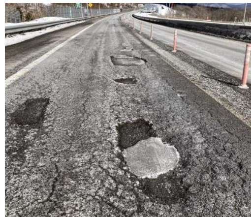
路面損傷状況
