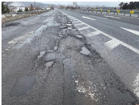
路面損傷状況
