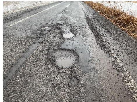
路面損傷状況
