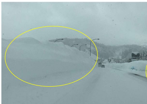
雪庇発生状況
