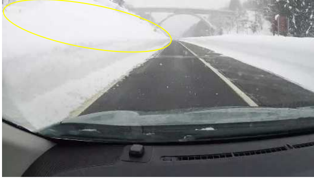
雪庇発生状況
