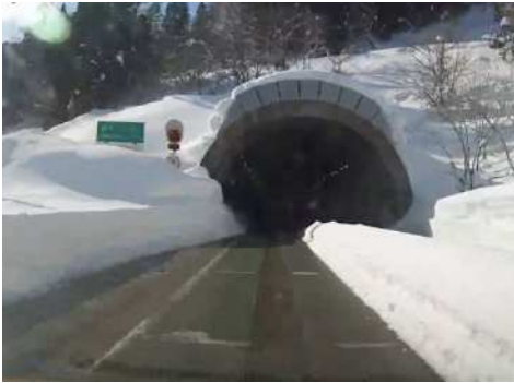
トンネル坑口付近堆雪状況
