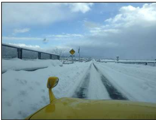
路肩堆雪状況
