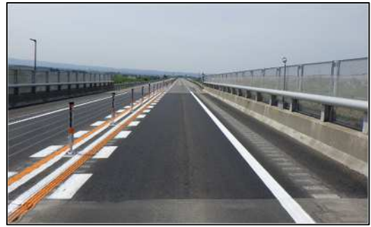
ワイヤロープ補修後イメージ
