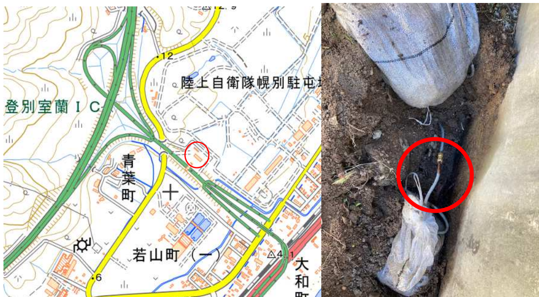
(配管破損状況)
