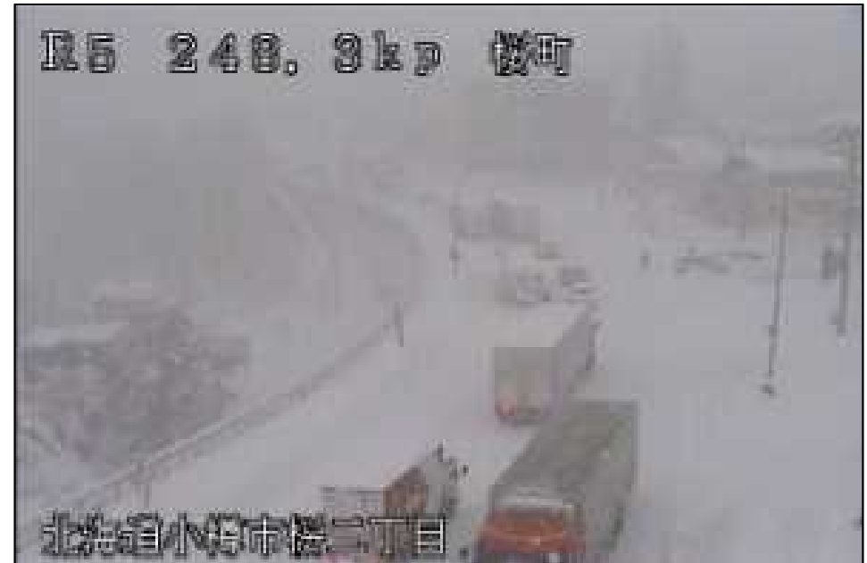
国道5号 小樽市桜町 通行止め時の状況
