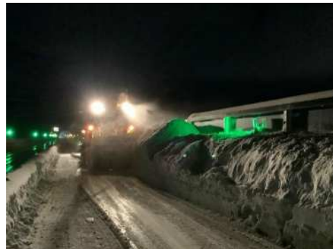
北海道支社管内 札樽道の積雪と除雪状況 (令和5年1月10日)
