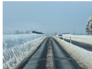
中央分離帯-路肩(橋梁部)
