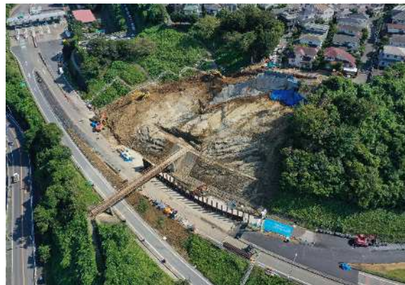
②復旧工事状況(R3.9.15撮影)
