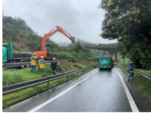
復旧作業状況
