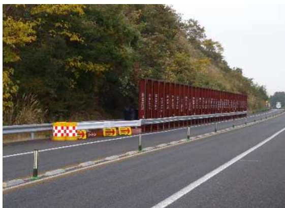
落石防護柵設置(イメージ)
