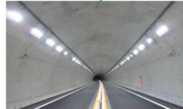
①トンネル照明のLED化によるエネルギー使用量の最小化
