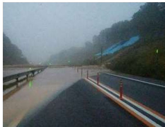
[道東自動車道(トマム～十勝清水)、 出所: 東日本高速道路]
