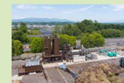
バイオマスガス化発電プラント
