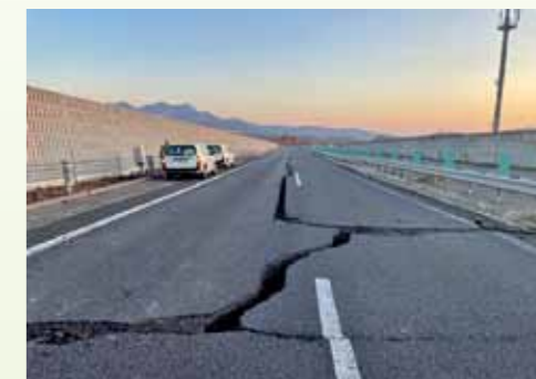
2022年3月16日 福島県沖地震 被災直後の状況 (東北道 国見IC~白石IC間)
