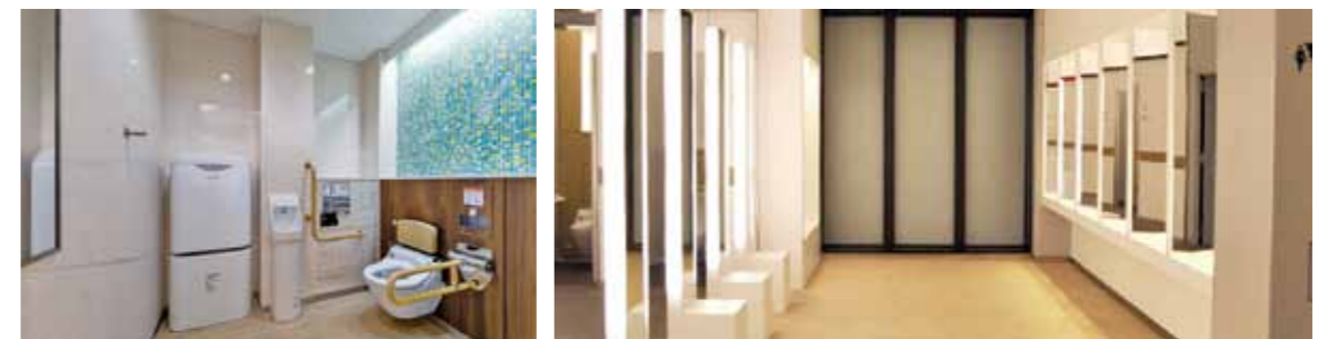
大型ブーストイレ(左)や女性用トイレにパウダーコーナー(右)を設置しています。
