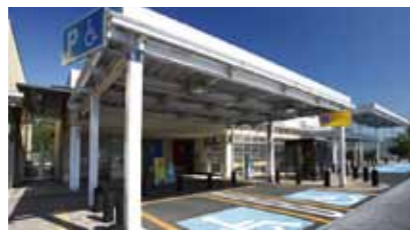
障がい者等用駐車場
