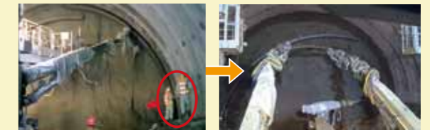
機械による自動施工によりトンネル掘削箇所付近の立入人数を削減
