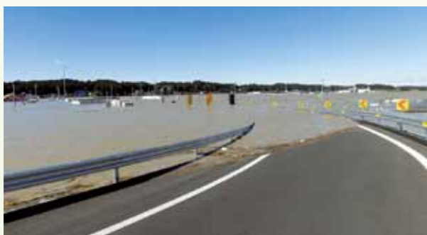
河川からの越水によるICの冠水の様子
