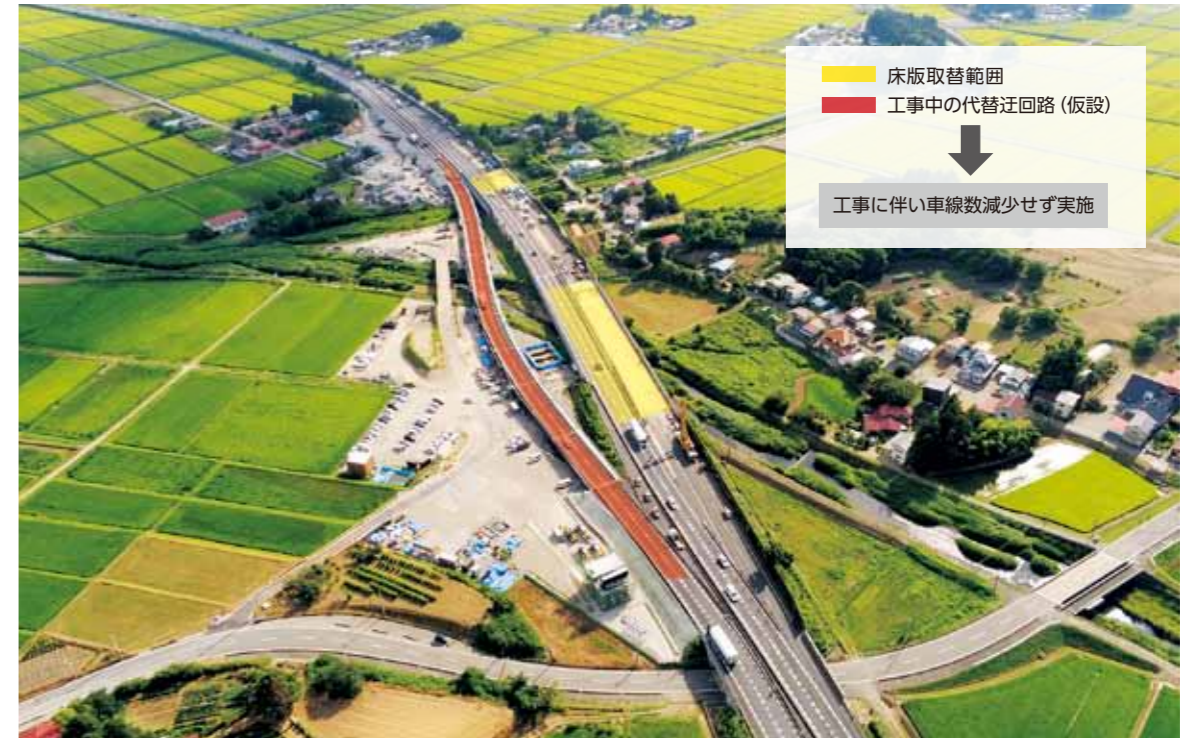
床版取替工事(東北道 原瀬川橋)
