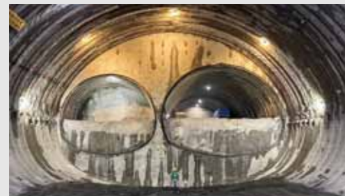
横浜環状南線 金利谷戸トンネル (最大断面積485㎡・幅29mの大断面トンネル)
