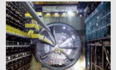
大泉JCT本線シールド(南行)発進立坑付近
