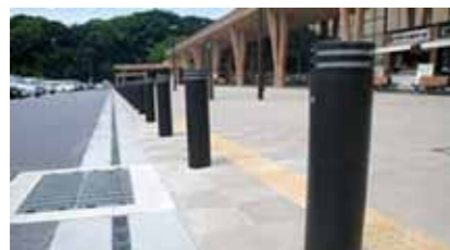
駐車場と歩道の段差解消
