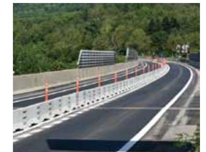
橋りょう部のセンターブロック
