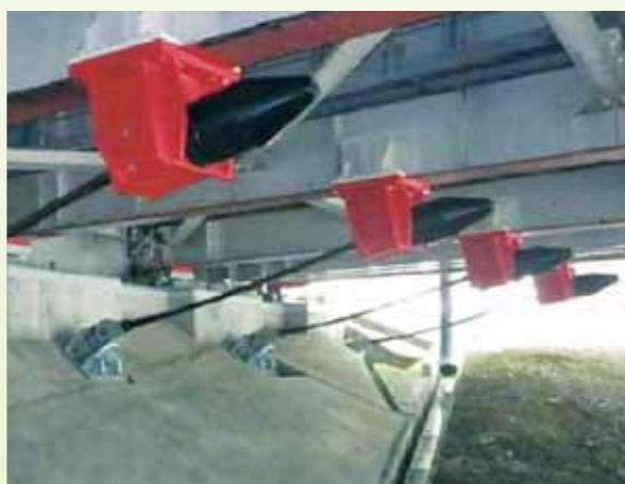
落橋防止装置の設置例
