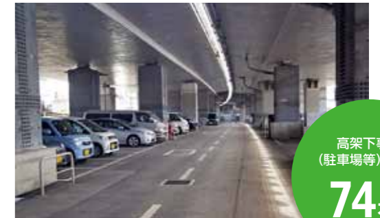
東北道 岩槻高架下駐車場
