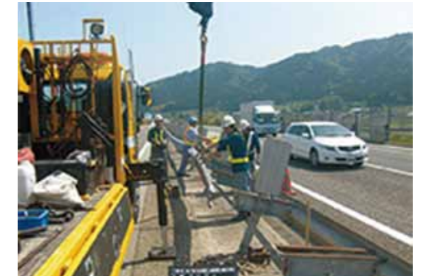
補修工事の様子
