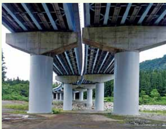
橋脚補強(巻き立て)工事の例
