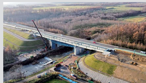
道東道 トマムIC～十勝清水IC ベケレベツ川橋
