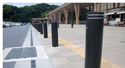
駐車場と歩道の段差解消
