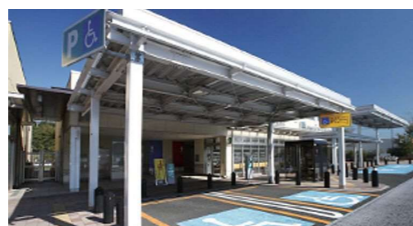
障がい者等用駐車場
