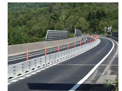
橋りょう部のセンターブロック
