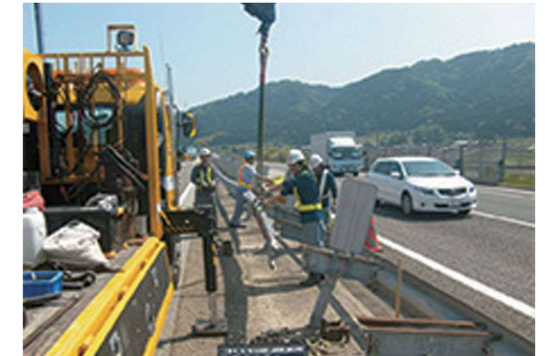
補修工事の様子
