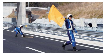
落下物排除の様子
