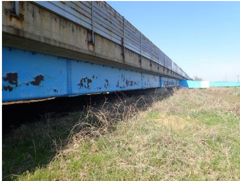
【塗装劣化部の塗替塗装
