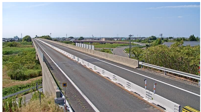
【センターブロック設置状況】
