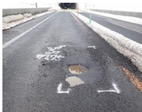
【緊急補修が必要な路面損傷の補修状況（土木）】
