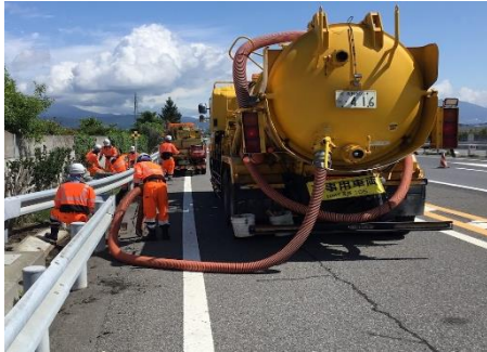
【排水溝清掃状況】
