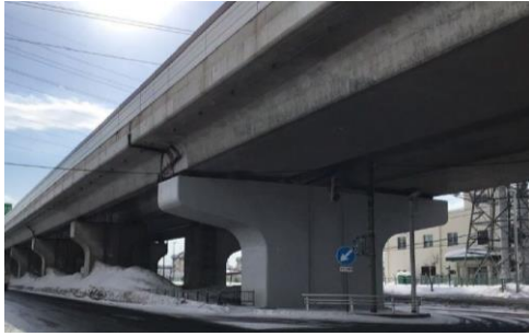
【上部工損傷部の補修
