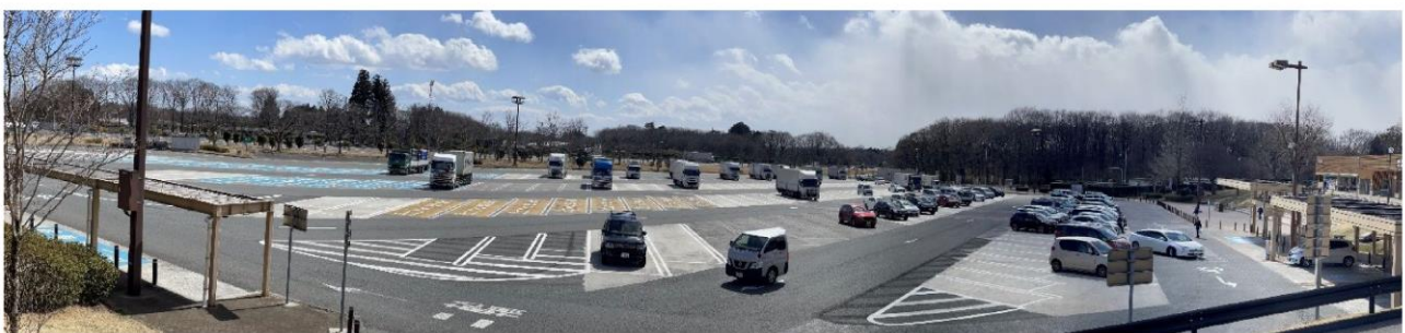
写真-3 レイアウト変更後の状況 (E4 東北道 那須高原 SA (下り))
