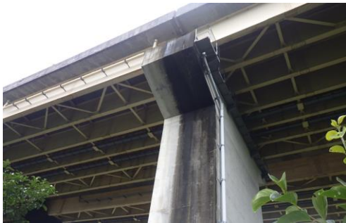
【下部工損傷部の補修
