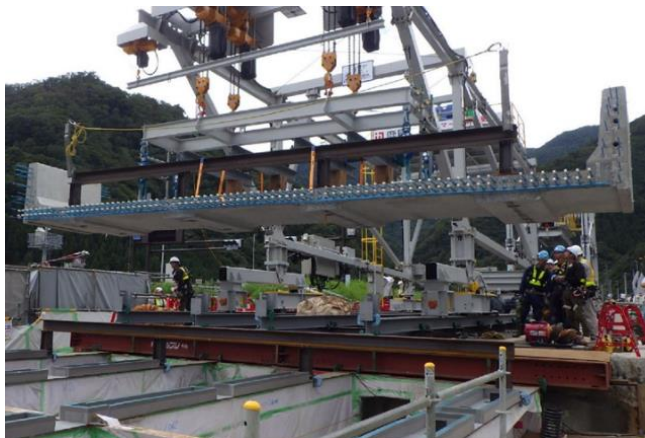
【関越道 阿能川橋床版取替工事状況】
