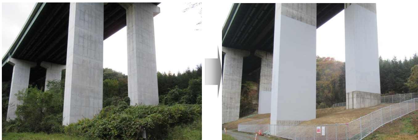
【補強前後の橋脚（常磐道 檜川橋）】
