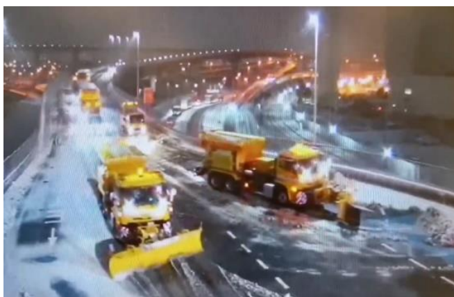
【集中除雪 実施状況（外環道）】
