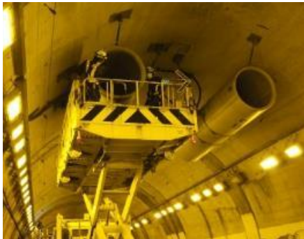
【トンネル換気設備の点検（施設）】
