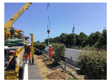
【緊急作業及び事故復旧作業状況】
