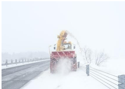
【雪氷対策作業状況(路肩除雪)】
