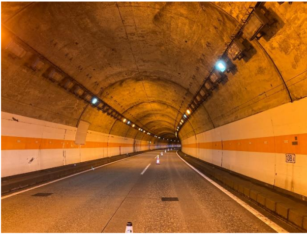
【トンネル照明設備の更新（LED化）
