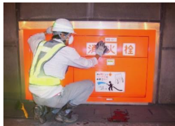
【施設（消火栓）清掃状況】
