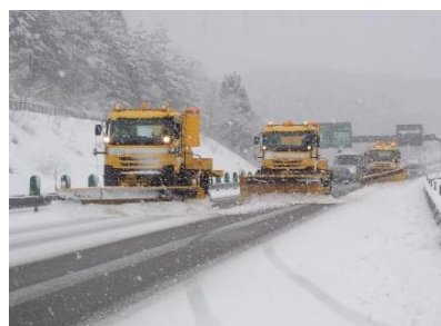
【雪氷対策作業状況(本線除雪)】
