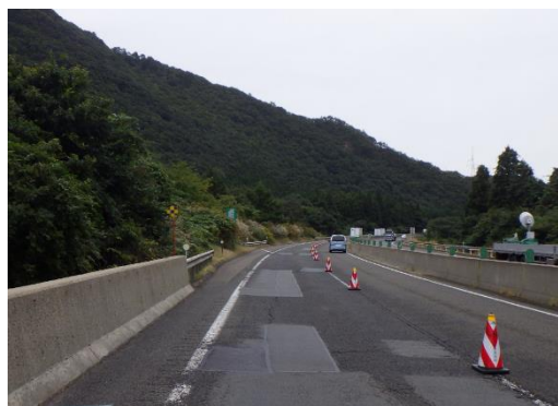
【舗装の補修 東北道 大衡 IC～古川 IC】
