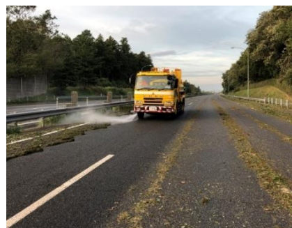
【改良した散水ノズルでの清掃状況】
