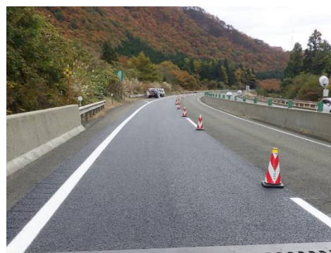
【舗装の補修 山形道 宮城川崎 IC～笹谷 IC】
