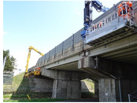
【詳細点検（土木）】
