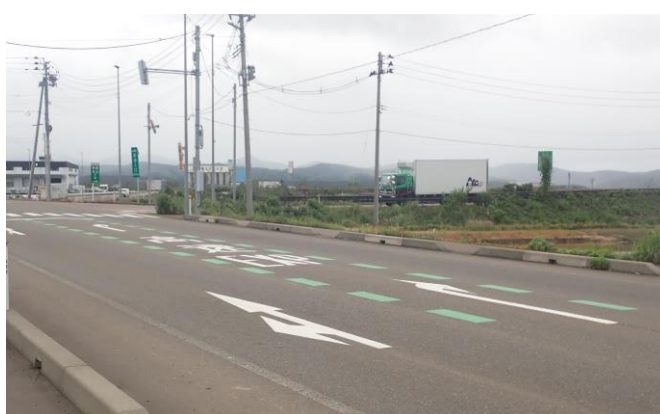
高速入口路面標示・看板 【北陸道 長岡北スマートIC（上）】
