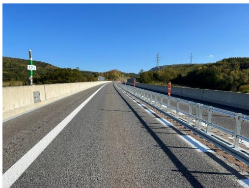
【センターパイプ設置状況】
