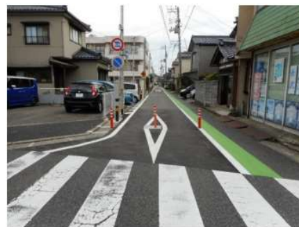
写真：新潟県新潟市日和山小学校 (平成 30 年 4 月本格導入) (ソフトライジングボラード)
