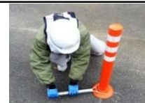
固定ボルト締付確認
